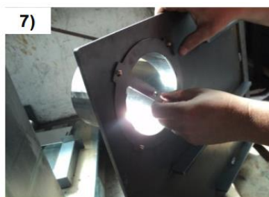
7) Montera tätningsbandet som har följt med kökspannan, montera tillbaka ringen och sen dra fast den med de fyra muttrarna
